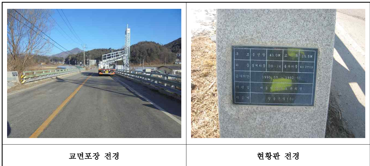
【사진 2.3.8】 교면포장 전경
