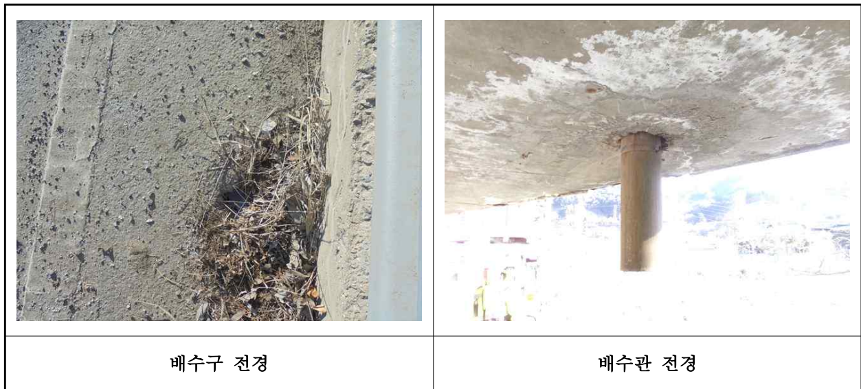
【사진 2.3.10】 배수시설 전경
