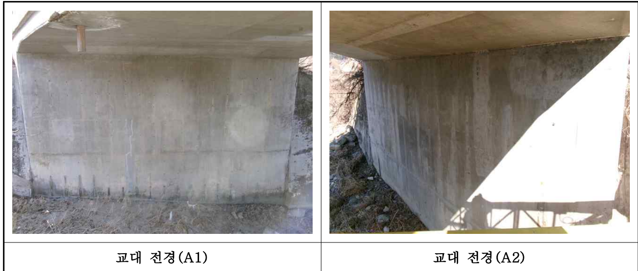
【사진 2.3.4】 교대 전경
