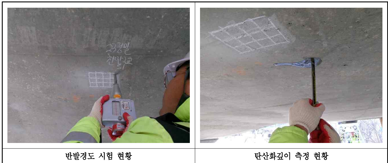
【사진 2.4.1】 콘크리트 내구성조사 현황
