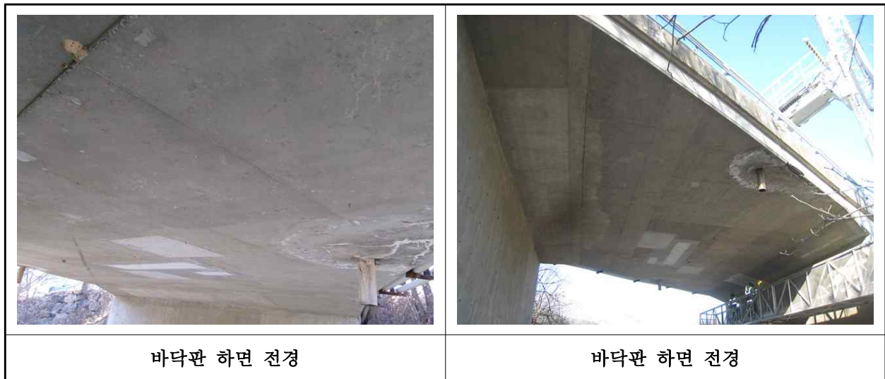
【사진 2.3.2】 바닥판하면 전경
